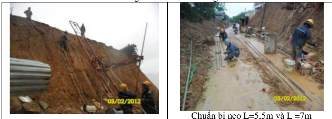
Bảng 3: Hình ảnh thi công
